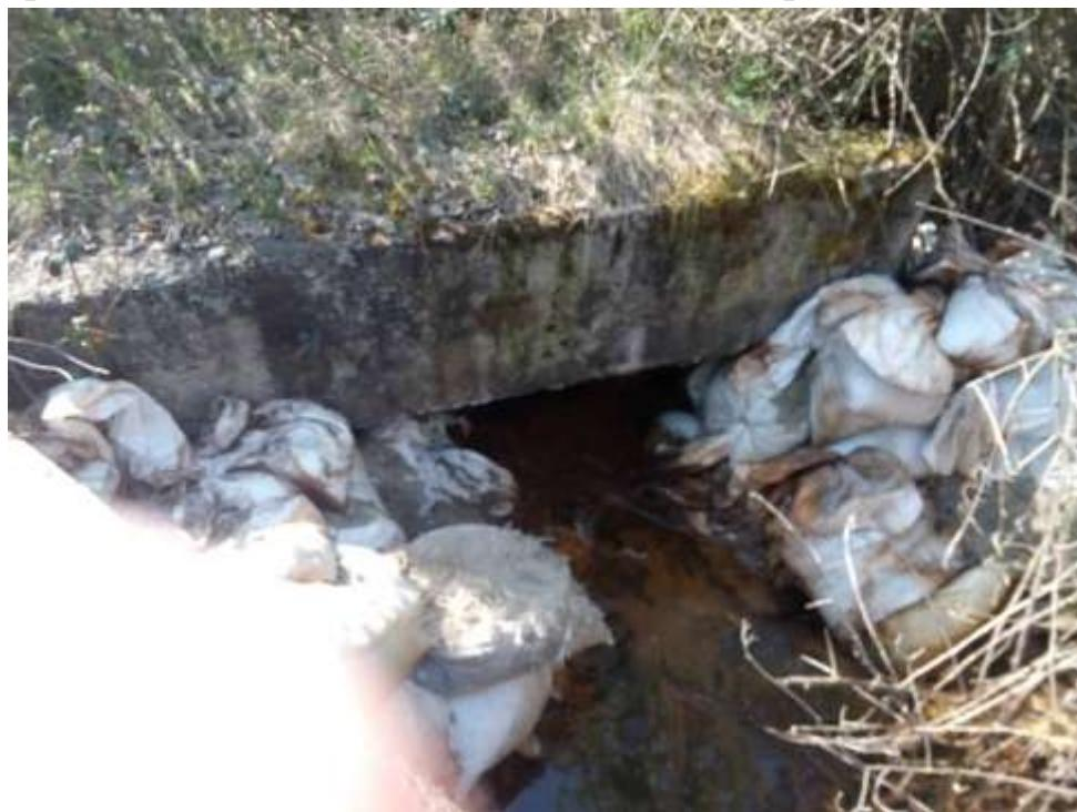
Apele pluviale din zona 3 si 2 erau evacuate dupa traversarea rambleului caii ferate printr-un canal paralel cu terasamentul caii ferate pana in zona serelor. Canalul s-a fost colmatat, au fost depuse deseuri din materiale de constructii, iar odata cu largirea podului peste calea ferata acesta a fost distrus si acoperit total, evacuarea apelor pluviale nemaiputand fi evacuate prin acest traseu.
